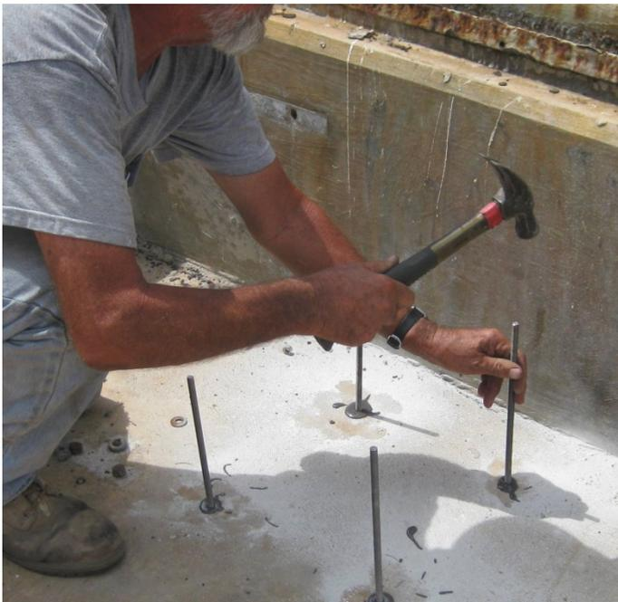
**Figure 5:** Après avoir rempli le trou avec la résine, les tiges filetées ont été insérées au marteau car le diamètre du trou était trop petit. Le diamètre de perçage nécessaire doit être clairement établi dans les instructions de pose des ancrages chimiques.
