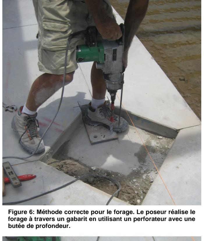
**Figure 6:** Méthode correcte pour le forage. Le poseur réalise le forage à travers un gabarit en utilisant un perforateur avec une butée de profondeur.
