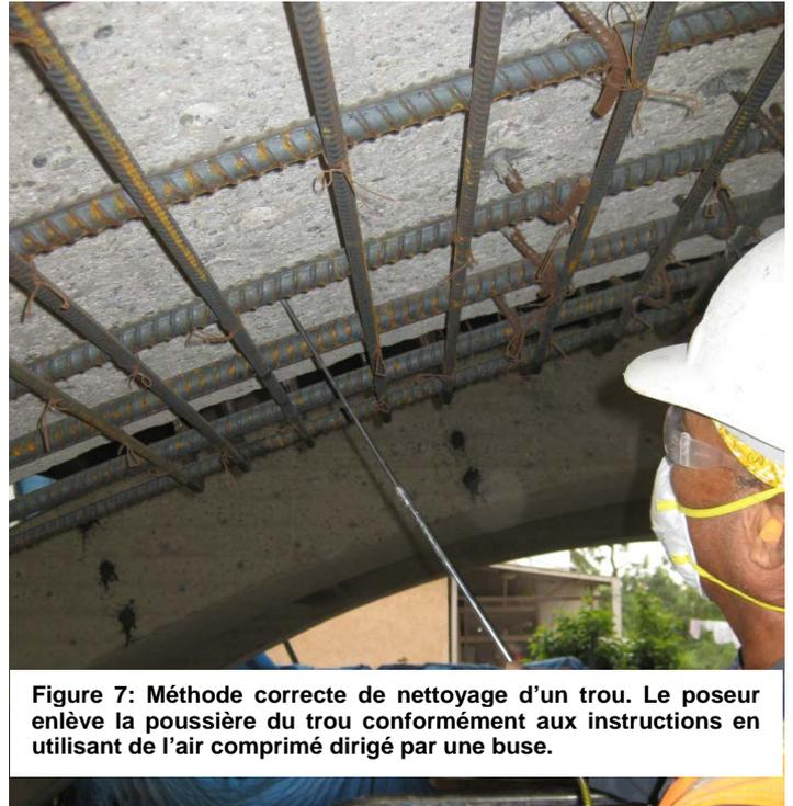
**Figure 7: Méthode correcte de nettoyage d'un trou. Le poseur enlève la poussière du trou conformément aux instructions en utilisant de l'air comprimé dirigé par une buse.**
