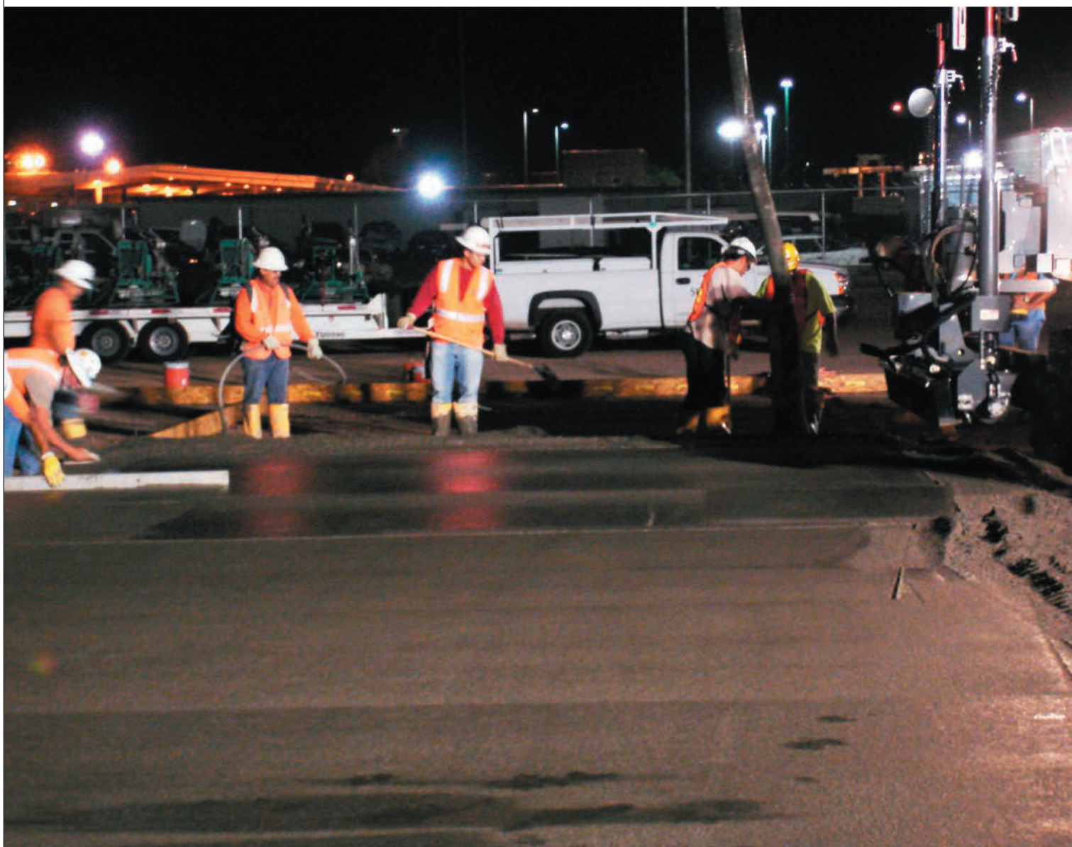
Fig. 2: Una cuadrilla utiliza una bomba y una enrasadora láser para colocar una losa de concreto reforzado con fibras. A diferencia del concreto sin fibras de acero, con frecuencia ocurren bloqueos en las líneas de bombeo debido a que el concreto está demasiado húmedo, en vez de estar demasiado seco.
