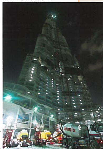
Groupes de pompage du béton au pied de la Burj Khalifa, lors de sa construction.
