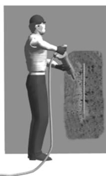
Concreto dañado retirado con un martillo cincelador de 15 lb. Los martillos de más de 15 lb pueden dañar el sustrato y el refuerzo.
