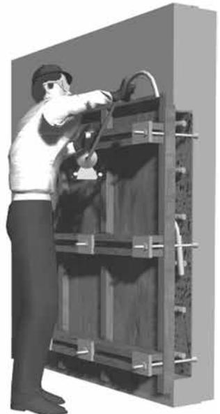
*El compuesto de curado se coloca inmediatamente con rodillo o aspersor sobre las superficies reparadas después de remover el encofrado. Un curado apropiado ayudará a asegurar que el material de reparación no se seque ni se agriete prematuramente y que desarrolle toda su resistencia.*
