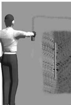
*Marque el perímetro del área por reparar. El trazado debe ser utilizando formas geométricas sencillas.*
