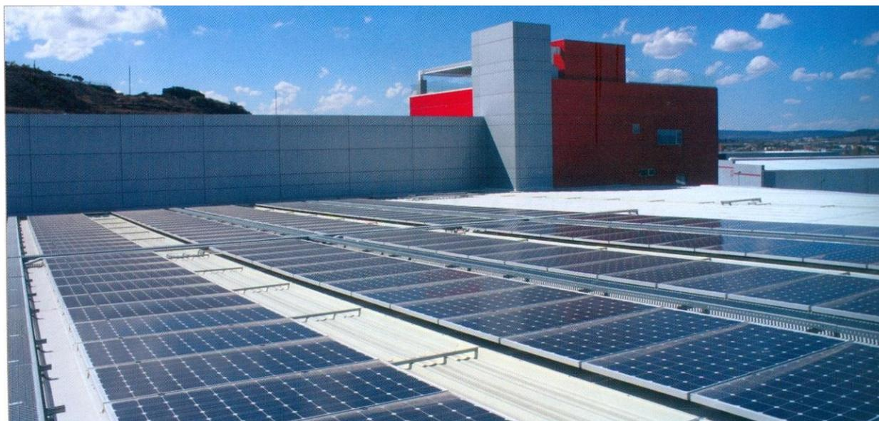
*Foto 1. Celdas fotovoltaicas, Centro de Innovación e Investigación en Energías Renovables, LEED NC v3 Nivel Platino, puntaje más alto de Latinoamérica. Los paneles fotovoltaicos cubren un 43% del consumo eléctrico del edificio.*
