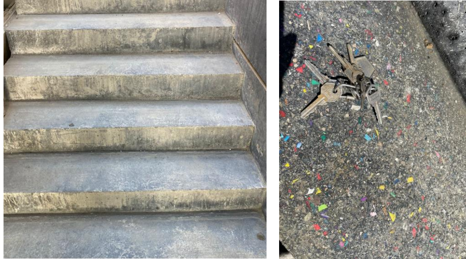
Proyecto Escaleras Plaza Comercial Iturbide Ensenada, Baja California Concreto ECO con PET Triturado
