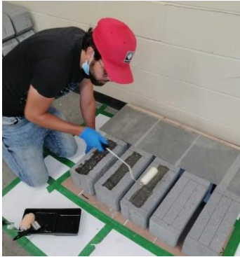
2. Applying of the primer epoxy resin "Primer layer".
