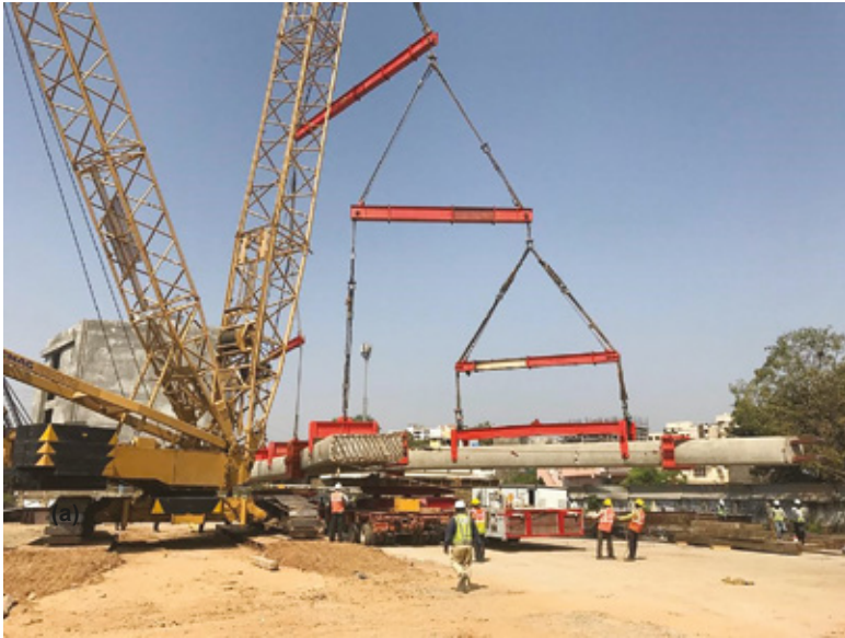
Figura 9: Una columna HY es levantada por dos grúas.
