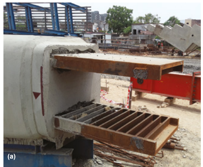
Figura 11: Una columna HY se baja sobre anclajes de acero en la cimentación
