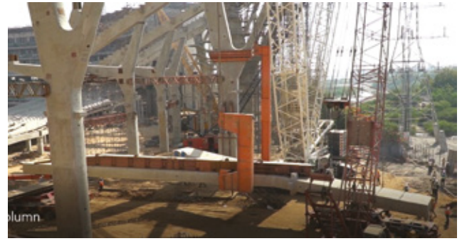
Figura 9: Una columna HY es levantada por dos grúas.
