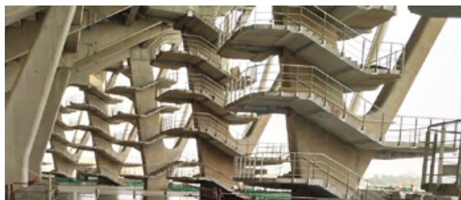
Fig.15: Escaleras de acceso y salida en columnas HY
