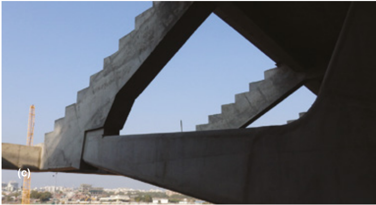
Fig. 12: Las columnas se fabricaron con elementos de acero estructural empotrados en puntos de conexión superiores: (a) muestra elementos empotrados que se extienden desde el extremo de la columna; (b) muestra los huecos correspondientes en la parte inferior del PRB; y (c) muestra una conexión completa de un extremo de columna a un PRB.
