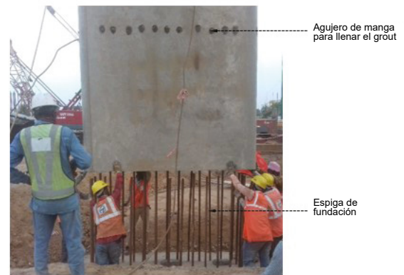
Figura 11: Una columna HY se baja sobre anclajes de acero en la cimentación
