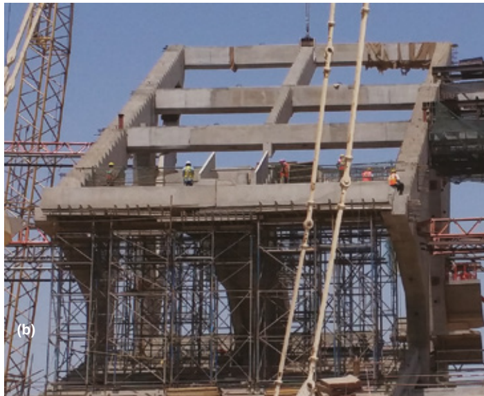
Figura 14: Se apoyaron vigas radiales secundarias (SRB) sobre vigas circunferenciales: (a) vista de una viga secundaria inferior; y (b) vista de un pórtico completo.
