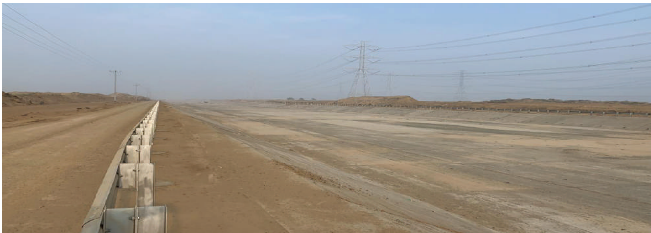
El canal de concreto reforzado terminado en Jizan dirigirá el agua de escorrentía lejos de las carreteras y las instalaciones de producción industrial (foto cortesía de Al Yamama Group)
