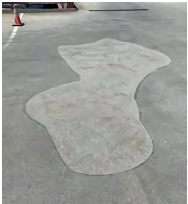
Fig.7: Una losa de estacionamiento en Utica, NY, E.U.A. reparada con el material de reparación modificado con caucho, después de 4 años en servicio
