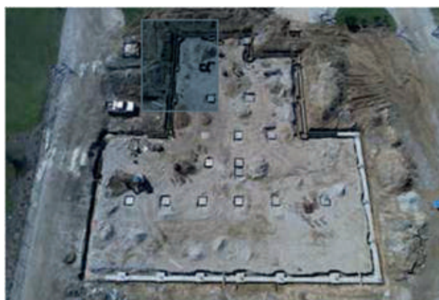
Fig. 1: Zapata de cimentación continua
