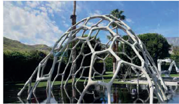
Fig. 8: El Mars Canopy se construyó sin barras de refuerzo 20
