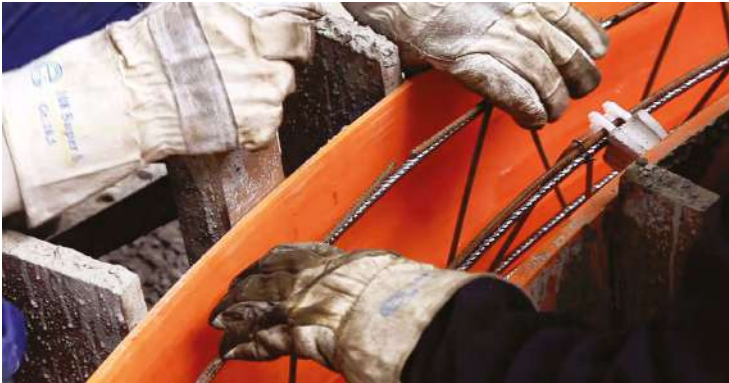
Un elemento de encofrado toma forma dentro de una impresora 3-D.
