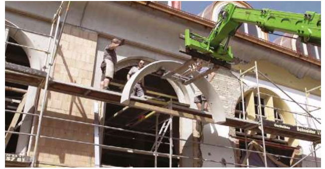
Elementos de hormigón se ensamblaron e instalaron en el sitio del proyecto.
