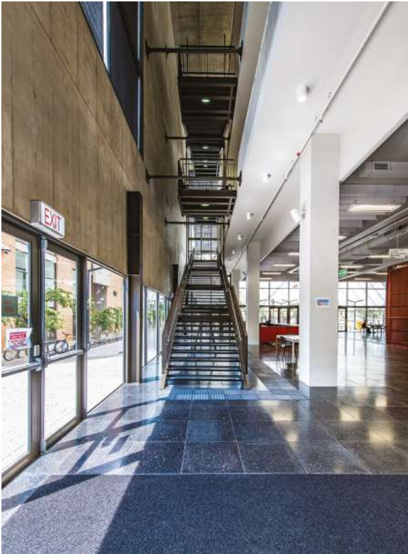
Figura.2: Las escaleras y el espacio abierto entre la fachada de concreto y el núcleo interno permiten que la luz natural entre en el edificio
