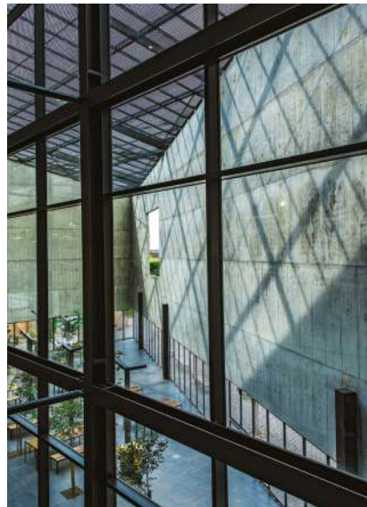
Figura.3: Los muros exteriores se apoyan en columnas de acero coladas en las zapatas y asentadas en el interior del muro
