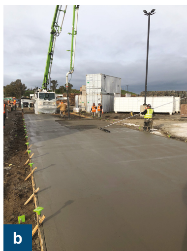
Figura 4: Pasos iniciales en la construcción de un panel de prueba de 20 x 80 pies (6 x 24 m) y 6 pulgadas (150 mm) de espesor utilizado para evaluar los efectos de los acabados de remolino y cepillo en los números F: (a) el encofrado, el refuerzo, la bomba y la cuadrilla están en su lugar; y (b) la colocación del concreto está a punto de completarse. El hormigón se bombeó, se hizo vibrar internamente, se niveló con una regla de 5 m (16 pies) de largo y se alisó con un flotador de canal de 2 m (6 pies)
