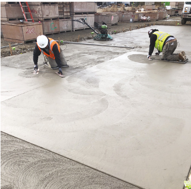
Figura. 6: Para un acabado con escoba, después del barrido, los acabadores en los rodapiés usaron una llana manual y una llana para preparar la superficie para el barrido. El acabado de remolino se colocó en la superficie panoramizada.
