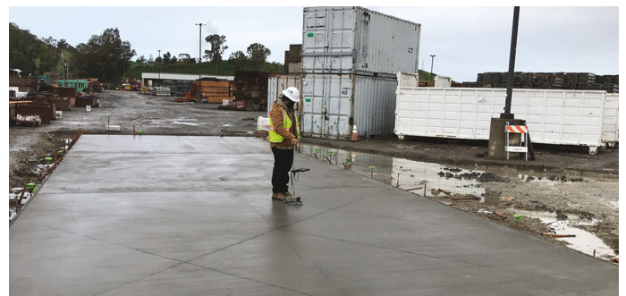
Figura. 7: El técnico usa una varilla medidora para medir los números F en líneas de medición paralelas para cada sección del panel de prueba: remolino, escoba, flotador de plato y acabado de flotador
