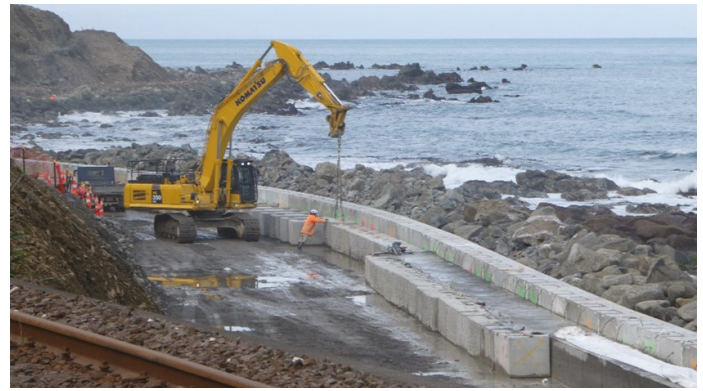
Figura 1: Paredes de retención RC-FRP en Kaikoura, Nueva Zelanda
