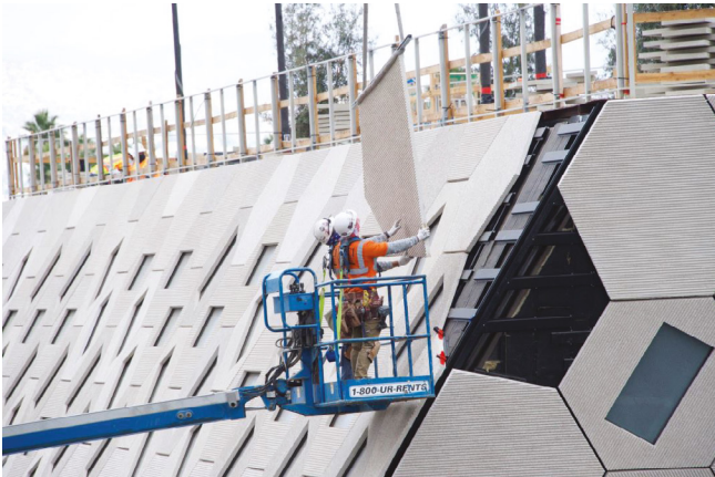
Figura. 5: Instalación de paneles de CRFV (fotos cortesía de Gary Leonard)
