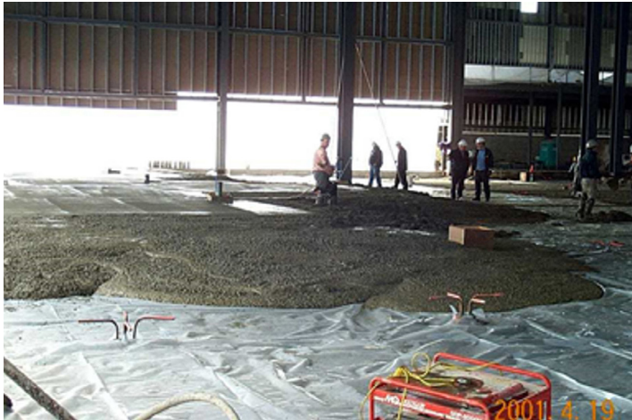
Figura 3: Losa sobre pilotes de SFRC diseñada según el método belga (Montréal-Mirabel, 2001). El concreto se colocó por descarga directa de camiones de concreto. Los pilotes están sobre un enrejado de pilotes de unos 4 x 4 m (13 x 13 pies) (se pueden ver cuatro varillas de refuerzo dobladas en cada pilote)
