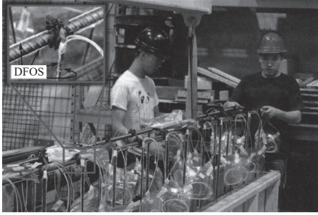
図 - 2 分散型光ファイバーセンサーの取り付け状況
