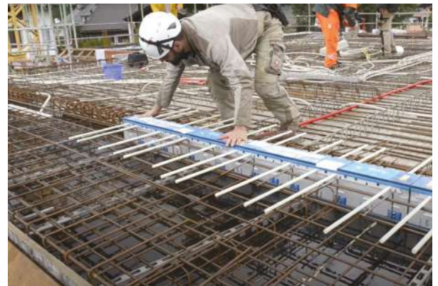
Fig. 1: Las roturas de puente térmico estructurales son relativamente ligeras y pueden ser instaladas por una persona siguiendo los manuales de instalación del producto e ilustraciones detalladas. Los extremos alternados de cada módulo se conforman para proveer juntas machihembradas y asegurar una instalación rígida y continua. La parte superior azul de cada módulo es un cabezal de polímero de protección (también hay disponibles cortafuegos). Nota: Las barras blancas en la foto son barras de polímero reforzado con fibra de vidrio (GFRP)
