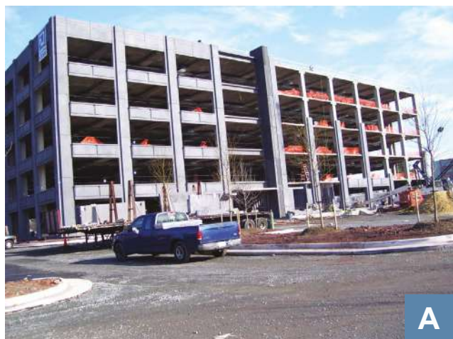
Fig. 6: Un edificio con elementos de fachada de hormigón prefabricado: (a) durante la construcción, la eflorescencia ocultó la belleza de los elementos; y (b) una limpieza final resultó en un mejor color y uniformidad.
