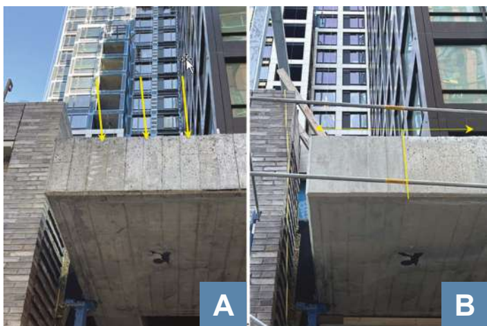
Fig. 4: Un dosel estructural: (a) la superficie vertical inicialmente exhibió numerosos agujeros de error; y (b) una foto de progreso muestra los beneficios de parchar y limpiar para mejorar la uniformidad.
