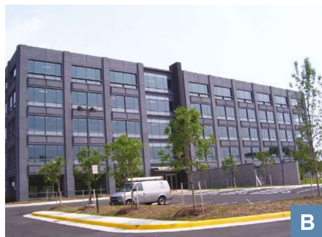
Fig. 6: Un edificio con elementos de fachada de hormigón prefabricado: (a) durante la construcción, la eflorescencia ocultó la belleza de los elementos; y (b) una limpieza final resultó en un mejor color y uniformidad.
