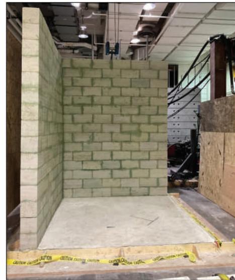
Fig. 3: Finalización de la construcción del muro de UMC (foto cortesía del laboratorio CIEST de la Universidad de Colorado Boulder).
