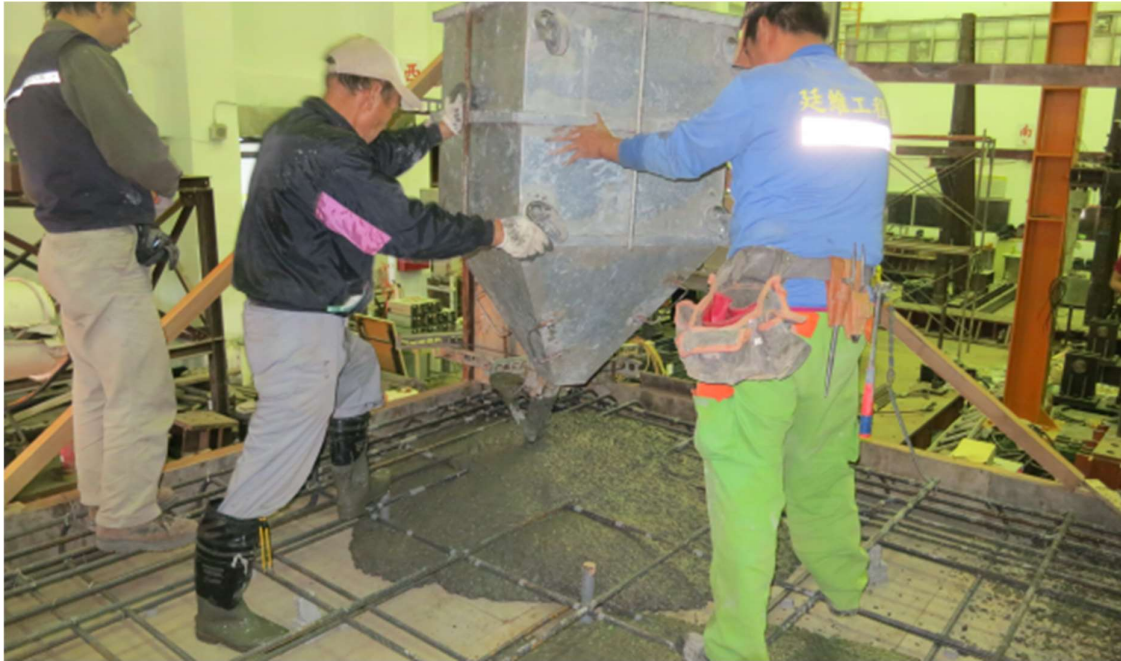
Fig. 3.9 – Concrete Pouring
