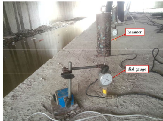
(d) Deflection gauges
