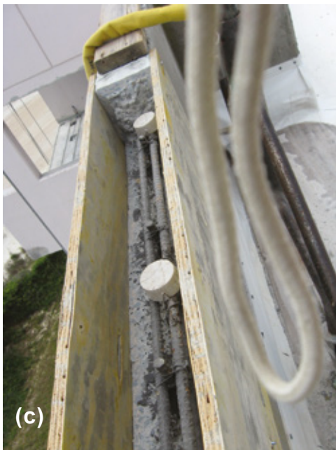
Fig. 5: Reparaciones en progreso: (a) refuerzo expuesto en pasillos; (b) refuerzo expuesto en parapetos; y (c) GCP y encofrado instalado en la reparación de parapetos
