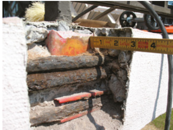
Fig. 2: Ejemplo de la excavación para pruebas durante la evaluación en 2007
