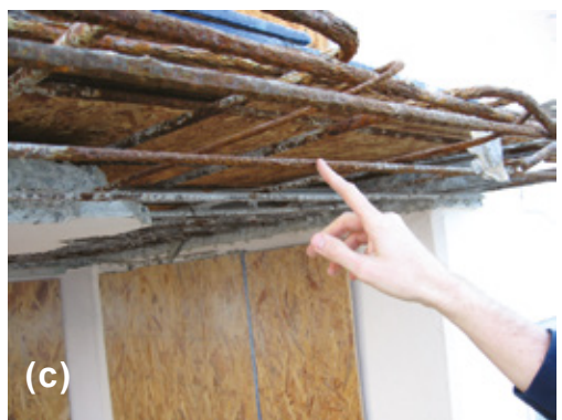
Fig. 4: Reparaciones de balcones: (a) acceso general a la construcción con plataformas colgantes; (b) extensión de daño; y (c) uno de los balcones con daños más severos necesitando el uso de puntales. Nótese la ausencia de paredes en las puertas deslizantes de vidrio en los balcones
