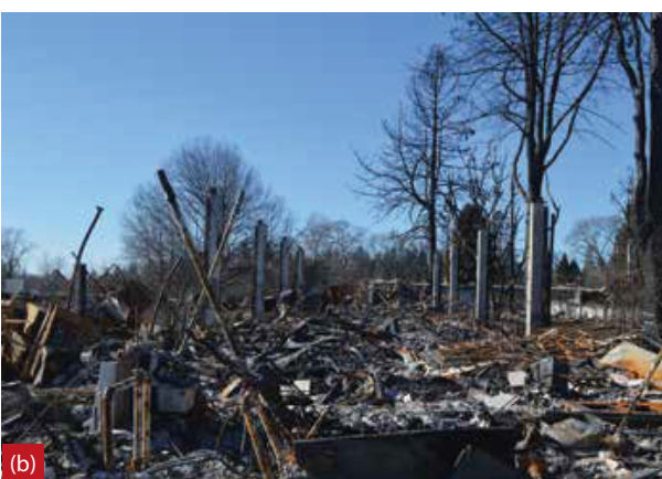
Fig. 9: Restos de edificios destruidos en Camp Fire: (a) Stratton Market; y (b) Escuela Primaria Paradise (fotos cortesía de Erica Fischer)
