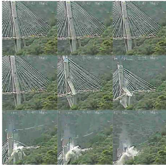
Fig.8: Secuencia de falla de la torre oeste del puente Chirajara (después de la Referencia 29)
