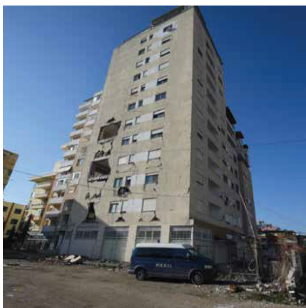
Fig.10: Un edificio de estructura RC de mediana altura dañado en Albania
