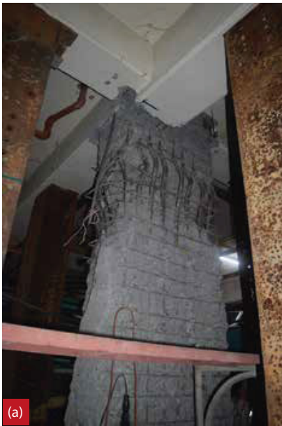
Fig. 4: Daños a columnas en el terremoto de Taiwán de 2016: (a) falla por compresión axial; y (b) falla por corte (después de la Referencia 22, con licencia CC BY-NC SA 4.0)
