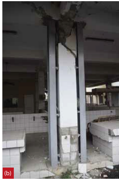
Fig. 4: Daños a columnas en el terremoto de Taiwán de 2016: (a) falla por compresión axial; y (b) falla por corte (después de la Referencia 22, con licencia CC BY-NC SA 4.0)
