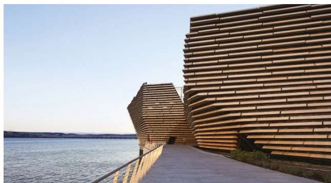
Figura 3: Las estrías en la fachada invocan imágenes de los despeñaderos de la costa marítima escocesa (fotografía cortesía de HUFTON + CROW)
