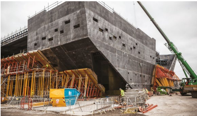
Figura 8: Paredes de fachada permanecieron apoyadas hasta que las placas del piso, vigas y losas fueran aseguradas a la estructura y el concreto alcanzara su fuerza de diseño
