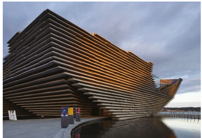
Figura 10: La apariencia de acantilado en el exterior del edificio fue ejecutado con 2429 paneles prefabricados de hormigón
