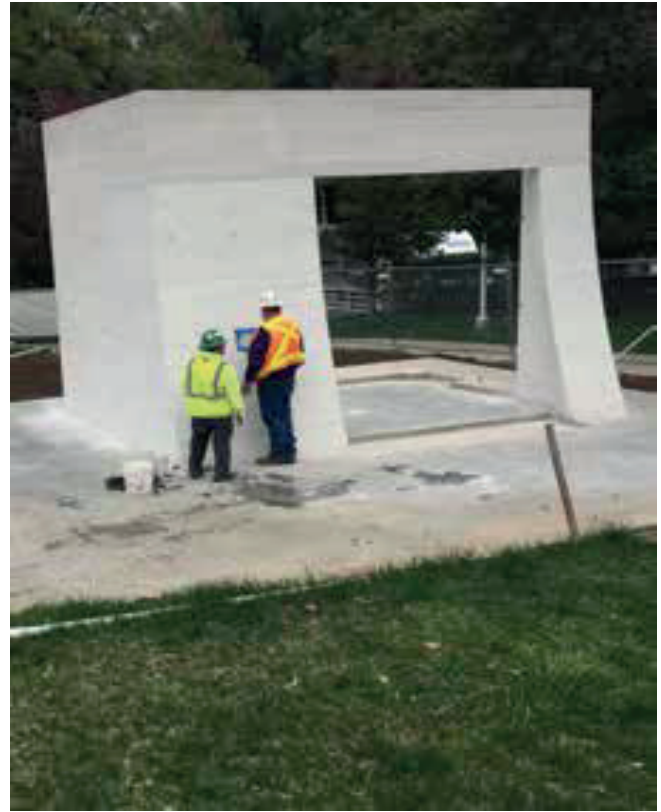
Fig.17: Se utilizaron maquetas visuales para probar conceptos de encofrado, amarres de encofrado (compuesto de acero o fibra), uniones, colocación de empotrados y parches.
