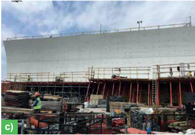
Fig. 9: La pared curva “característica” del “Skylight Pavilion” requería un sistema de encofrado extremadamente complejo: (a) las torres de encofrado iniciales sobre el sitio, adyacentes a la grúa torre (b) el acabado de la tabla machihembrada fue especialmente desafiante de crear en la superficie curva; (c) se requería un espaciado uniforme de los tirantes; y (d) la escala del muro se aclara con esta foto del equipo que conmemora la colocación final del concreto del muro.
