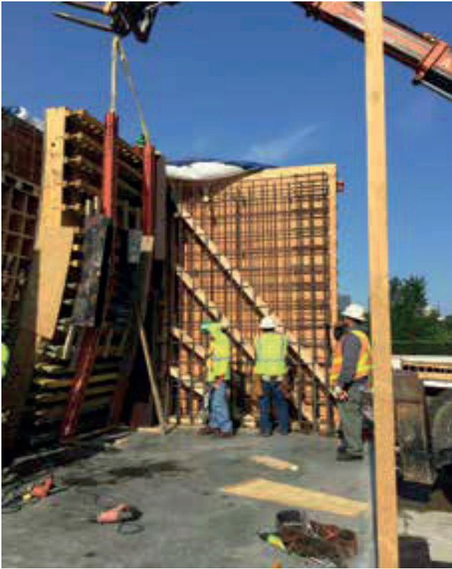
Fig.17: Se utilizaron maquetas visuales para probar conceptos de encofrado, amarres de encofrado (compuesto de acero o fibra), uniones, colocación de empotrados y parches.
