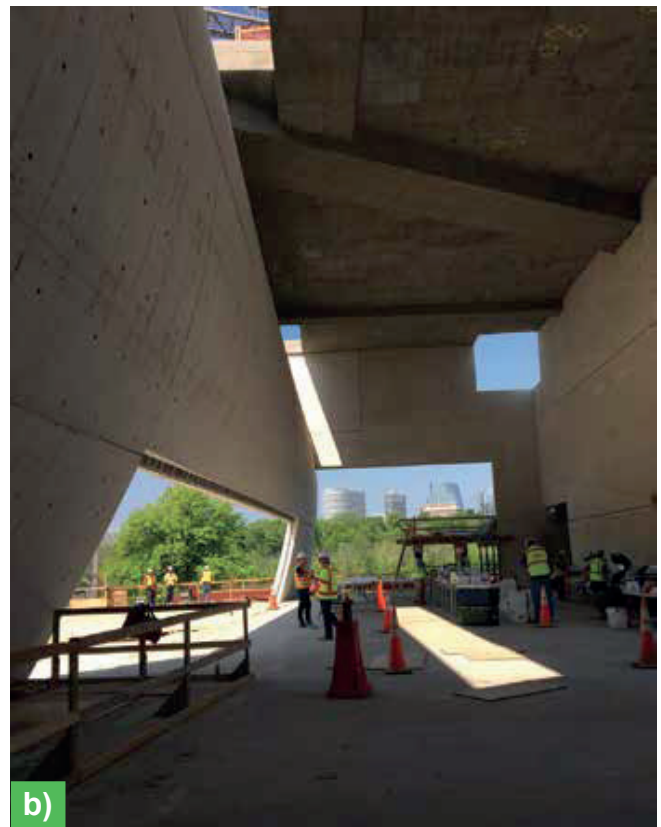
Fig. 7: El interior del Skylight Pavilion: (a) durante la instalación de la ventana de vidrio curvo con vista al río Potomac. El vidrio y el empotrado que forma su marco se fabricaron en Alemania para adaptarse a la
