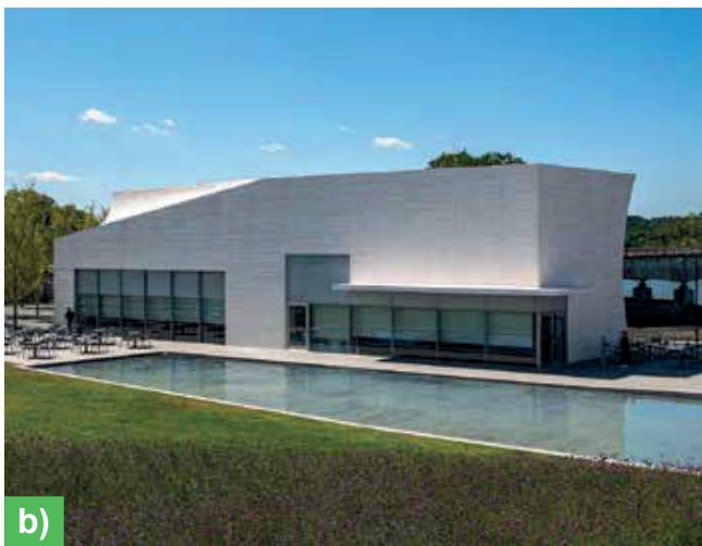
Fig. 10: Una losa de cubierta cónica es una característica destacada del River Pavilion. A diferencia de la losa cónica en el Welcome Pavilion, esta característica se colocó utilizando una sola capa de concreto blanco acabado manualmente: (a) una vista interior; y (b) una vista exterior
