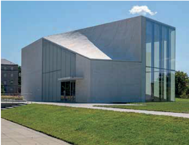
Fig. 6: La losa cónica comprende una capa de concreto estructural gris, una membrana de techo y una capa exterior blanca. La forma se logró utilizando tanto concreto moldeado como concreto lanzado.
