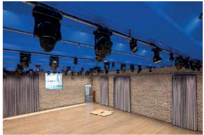
Fig.12: Studio K es una sala de usos múltiples que toma su nombre de la última inicial del difunto presidente. El espacio incluye paredes acústicas de concreto “texturizado” y un techo de concreto en forma de diente de sierra con luminarias integradas. El perfil del sofito de la losa de concreto se echó para que coincidiera con la forma del revestimiento azul. Aunque esta losa soportaba la cubierta verde y estaba postesada, no incluía formadores de huecos.
