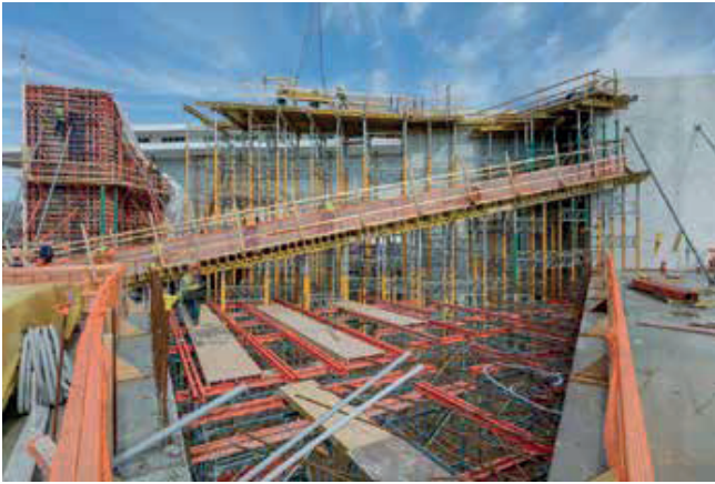
Fig. 5: Apuntalamiento y encofrado en el Welcome Pavilion. En el fondo, se colocó un apuntalamiento de 40 pies (12 m) de altura para la losa elevada del techo que forma el techo del atrio superior. En el centro de la imagen, se erigió un apuntalamiento de altura variable para la viga de concreto postensado de 92 pies (28 m) de largo necesaria para soportar la losa abovedada que forma un techo más bajo en el pabellón. El contorno de la losa abovedada se formó en cajas fabricadas con un enrutador CNC. Los boxouts fueron apoyados por los miembros de la cubierta naranja en primer plano.
