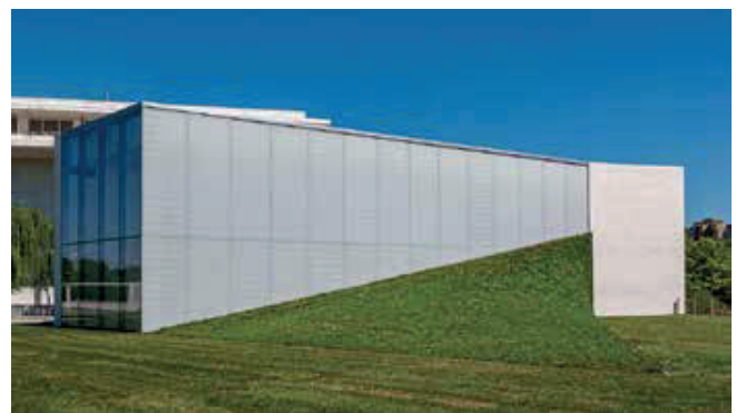
Fig.4: El techo verde cerca del Welcome Pavilion sigue los contornos de un techo abovedado en el pabellón de abajo.
