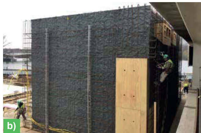
Fig. 14: Aunque se iban a pintar las paredes interiores, las superficies eran complejas y requerían mucha atención al detalle. Para mantener un patrón de orificios de unión de 5 x 4 pies (1,5 x 1,2 m) y permitir el uso eficiente de los revestimientos de encofrado de concreto texturizado, se utilizaron encofrados de montantes Aluma convencionales en lugar de encofrados modulares: (a) encofrado exterior para Studio K; y (b) encofrado interior y revestimientos de encofrado de concreto ondulado para el Justice Forum
