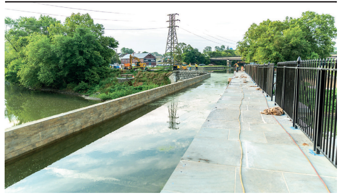
Una vista del lado del camino de sirga del acueducto que muestra el interior del muro de concreto que se estampó y tñió para darle apariencia de madera.
