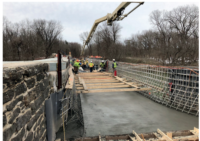
Colocación de la losa base (fotografía cortesía de Thomas, Bennett & Hunter, Inc.)
