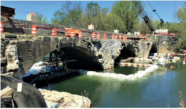
Reforzamiento de muelles y contrafuertes
