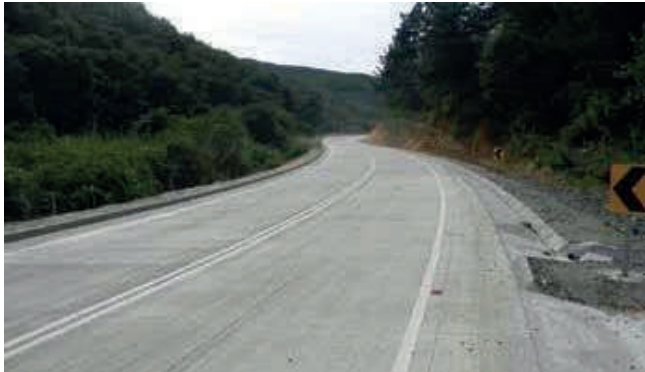
Fig. 4: Tramo de carretera de Cauquenes a Chanco en Chile
