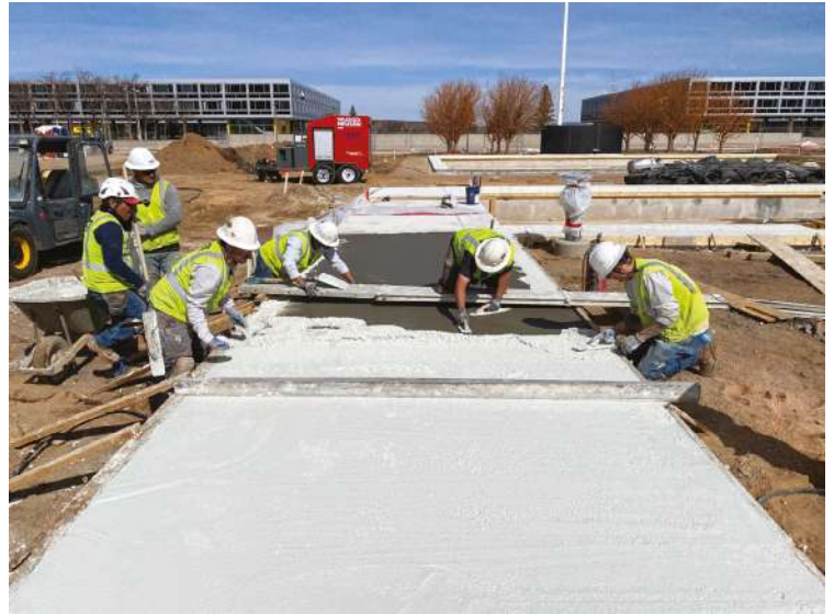
Figura.3: El cuidadoso proceso de aplicar recubrimiento de mezcla blanca en los corredores del Air Garden (fotografía cortesía de Colorado Hardscapes)
