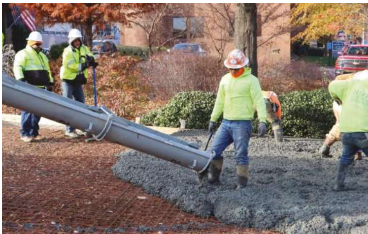
Figura 2: Colocación de la mezcla con CNC al 0.2% para el estacionamiento
