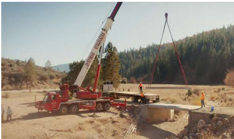
Figura 4: Colocación de las vigas cajón
