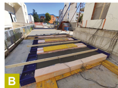
Fig. 1: Detalles del montaje de las losas: (a) cimbras de acero con película plástica antifricción, separadores o silletas tipo "serpiente" y varillas de anclaje roscadas (desde la izquierda, en exposición interior y exterior); y (b) especímenes después del colado (desde la izquierda, en exposición interior y exterior).
