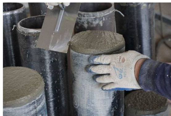
(d) Level the surface of concrete
