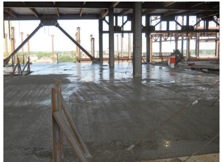
Exudación de agua en la superficie antes del acabado (foto cortesía de William H. Wolfe).
