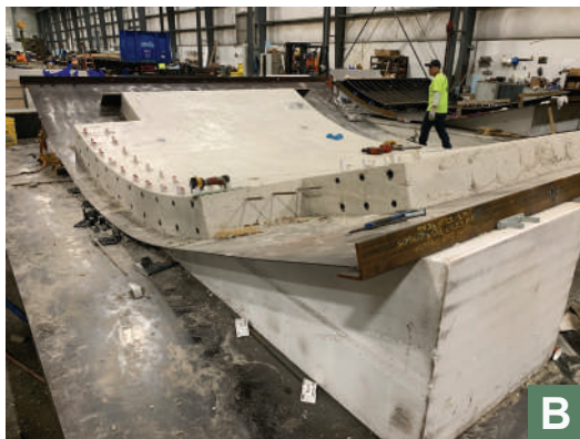
Fig. 5: Instalación de rejillas de refuerzo en un panel curvo (a) y el panel después del colado (b).
