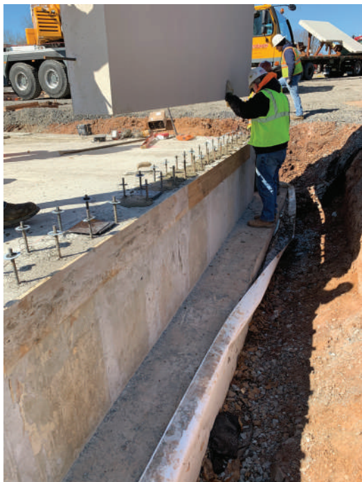
Fig. 6: Panel prefabricado instalado sobre barras de refuerzo instalado en el cimiento.
