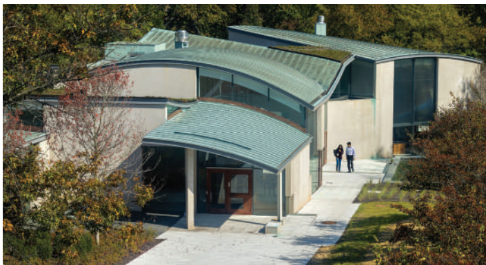
Fig. 3: Techo con diversos niveles de curvatura.
