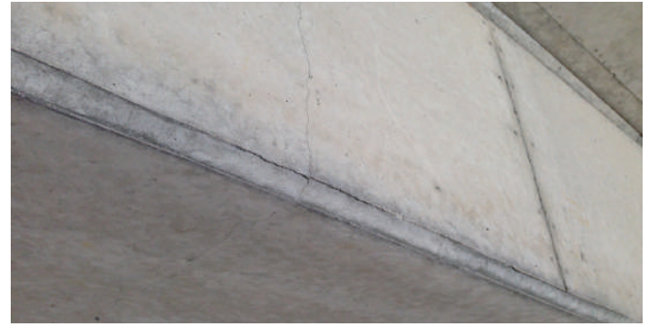
Fig. 2: Una viga dentro de la estructura de un estacionamiento: (a) una vista general; y (b) una vista en primer plano de una grieta en la cara de la viga y la losa.
