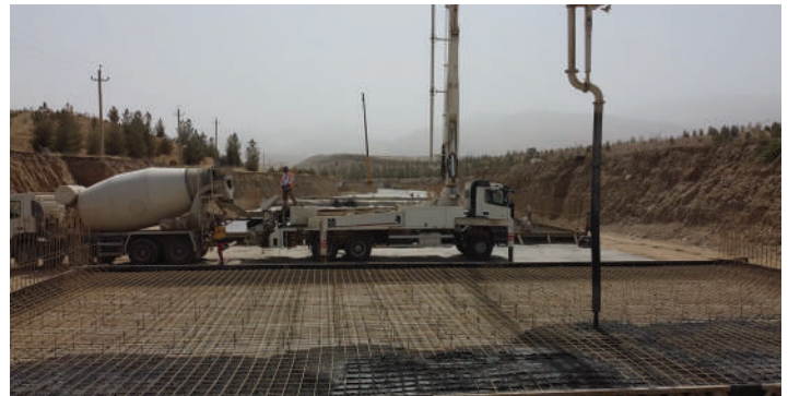
Fig. 5: Refuerzo de GFRP en losas de canal.
