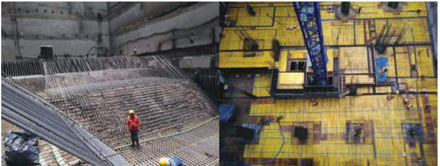
Fig. 5: Vistas de la losa de cimentación durante la construcción (fotos cortesía de Fernando Romo Consultores).
