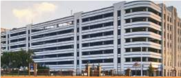
Fig 8. Estacionamiento de hospital en Texas con tecnología PS=Ø.
